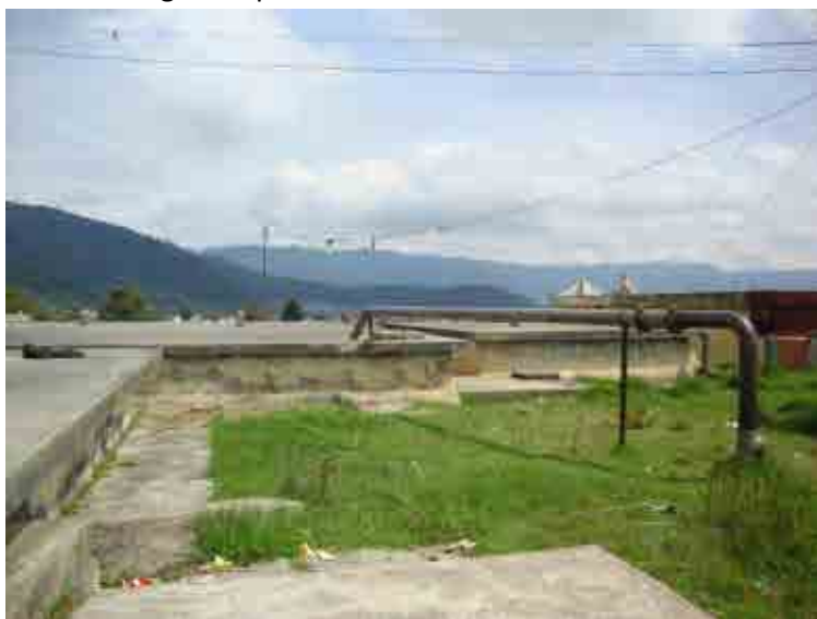
Imagen 18: Tanques de distribución de agua en el Cementerio
