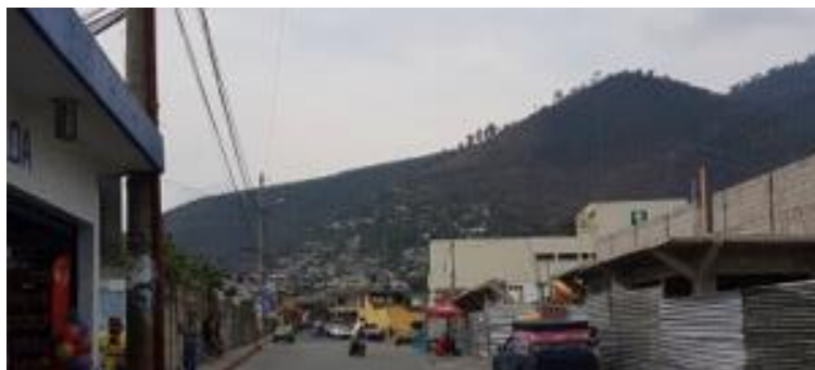
Imagen no. 13. Evidencia del alcance de la huella urbana en laderas, generación de riesgo. Jocotenango.
