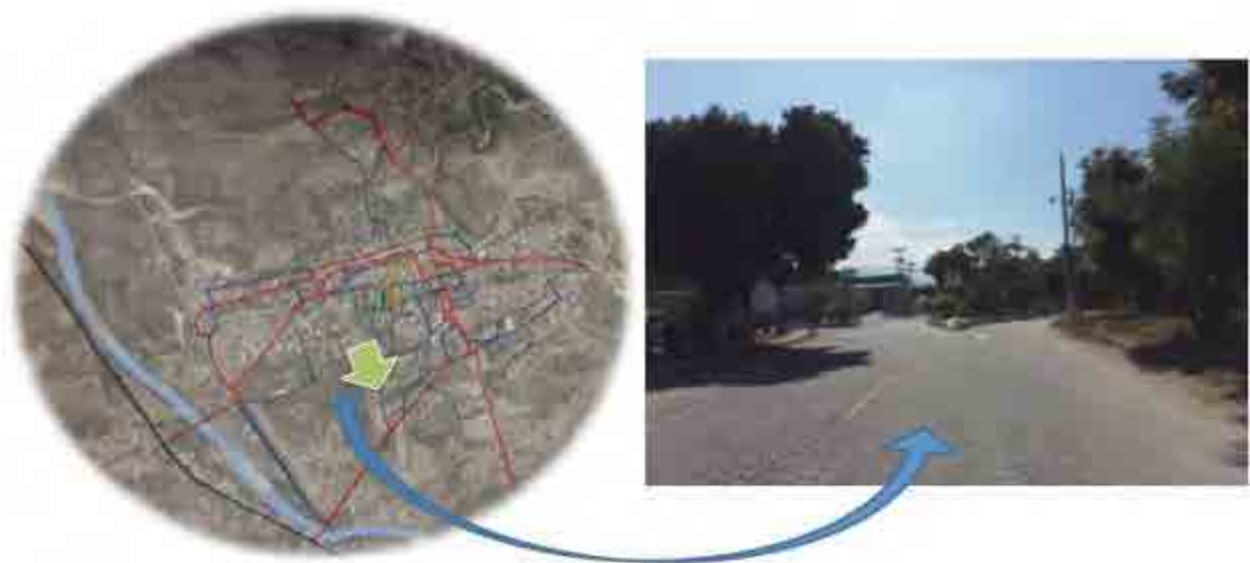
Figura 16 Ejemplo de vía secundaria de la ciudad de Zacapa
