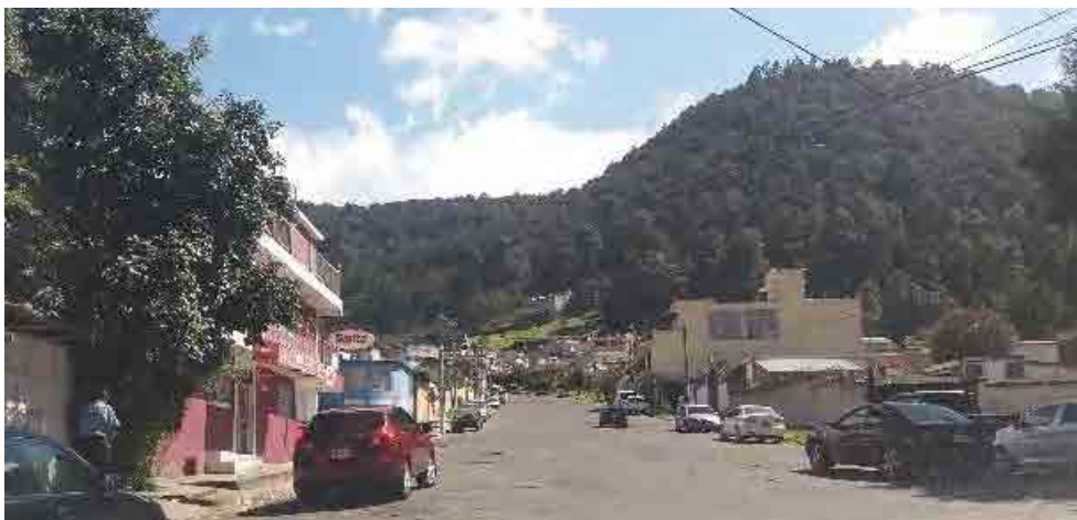
Imagen 25. Viviendas tradicionales de la parte alta con modificaciones, generalmente por construcción en el antejardín y segundo nivel.
