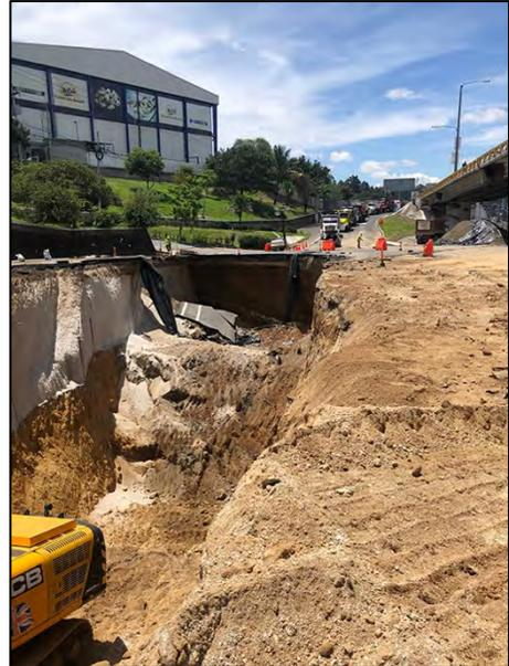
Movimientos de tierras, dentro del hundimiento, en el proceso de reconstrucción
