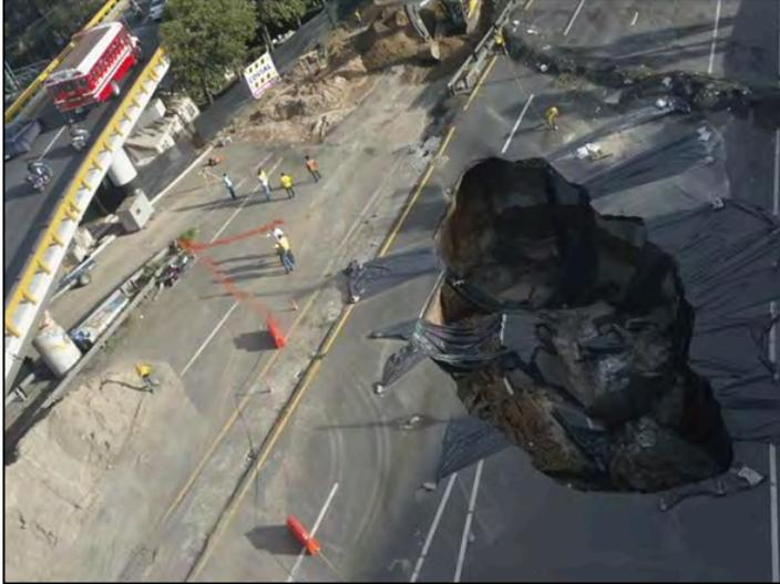
Imagen aérea durante proceso de colapso parcial del hundimiento km 15+500 en carretera CA-09-SUR
